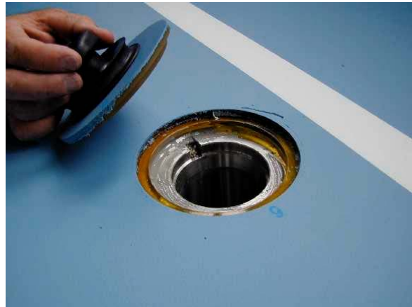
und nach einer Renovation
