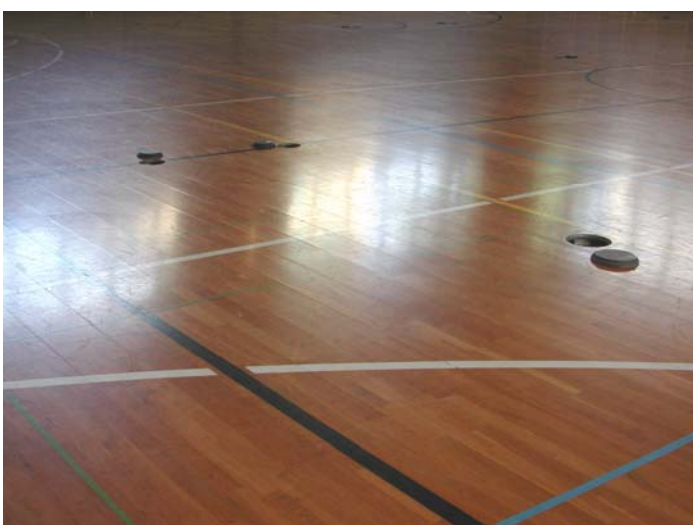
Halle nach 12 Jahren Benutzung: Anschliff und Neuversiegelung; Parkett ohne offene Fugen
