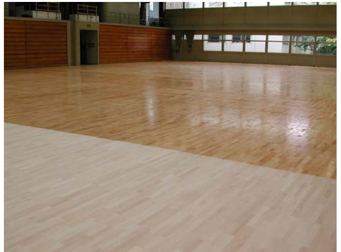
Einbau eines Schwingbodens mit Sport-Parkett und anschliessender Ortsversiegelung
