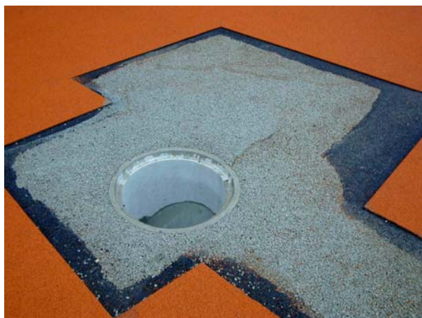
Sondages et installation d'un regard de visite supplémentaire
