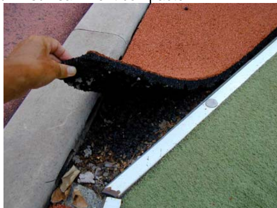
Décollage des synthétiques dû à un enrobé bitumineux insuffisamment compacté
