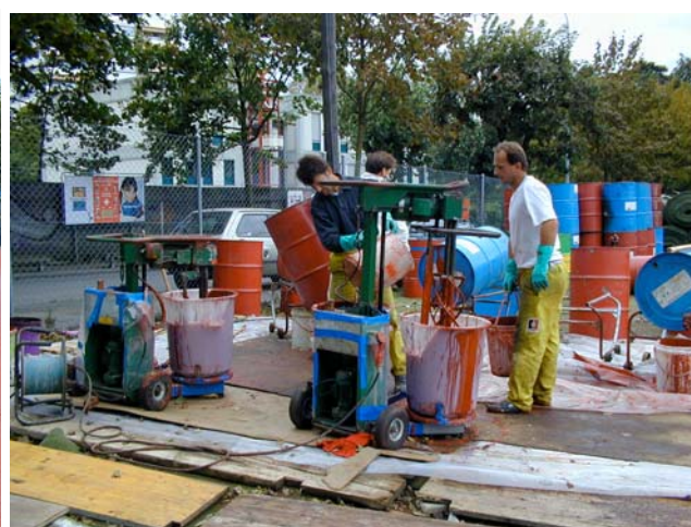
Application du polyuréthane chargé de granulats de caoutchouc sur la piste
