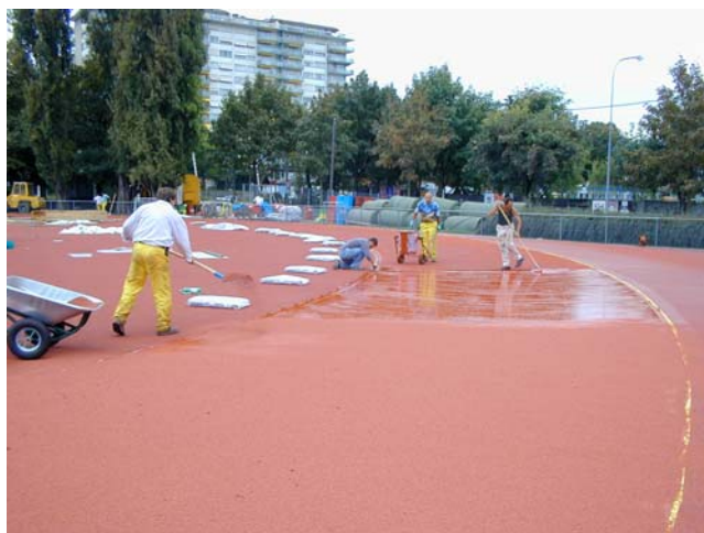
Application du polyuréthane chargé de granulats de caoutchouc sur la piste
