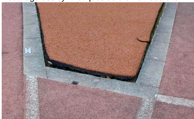
Décollage des synthétiques dû à un enrobé bitumineux insuffisamment compacté
