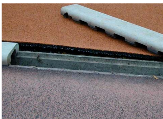
Décollage des synthétiques dû à un enrobé bitumineux insuffisamment compacté
