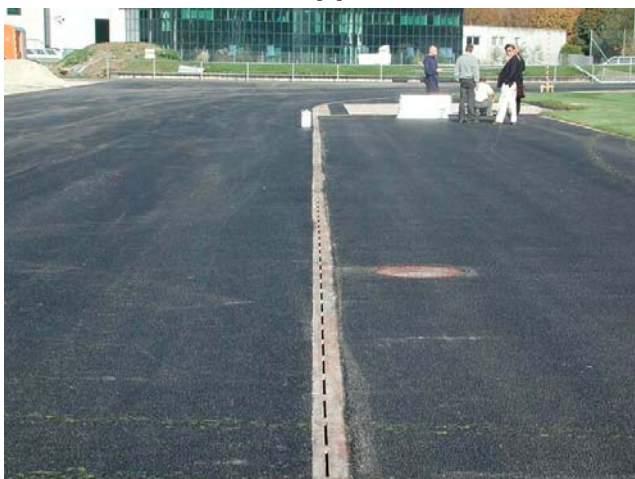
Pose du nouveau support un béton bitumineux, perméable à l'eau
