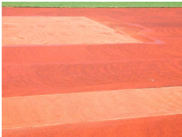
Application du bouche pore et le treillis (grille) de renforcement
