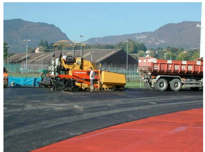
Pose du nouveau support un béton bitumineux, perméable à l'eau
