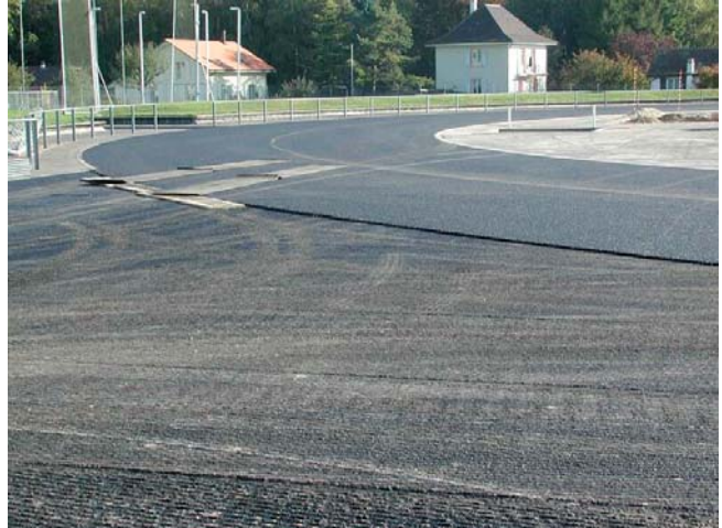
Pose du nouveau support un béton bitumineux, perméable à l'eau
