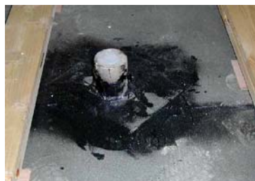
Pose de douilles indépendantes par rapport aux lambourdes et ...
