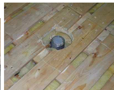
Pose de douilles indépendantes par rapport aux lambourdes et ...
