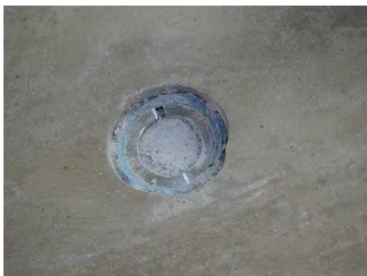
...pose de douilles dans des chapes.
