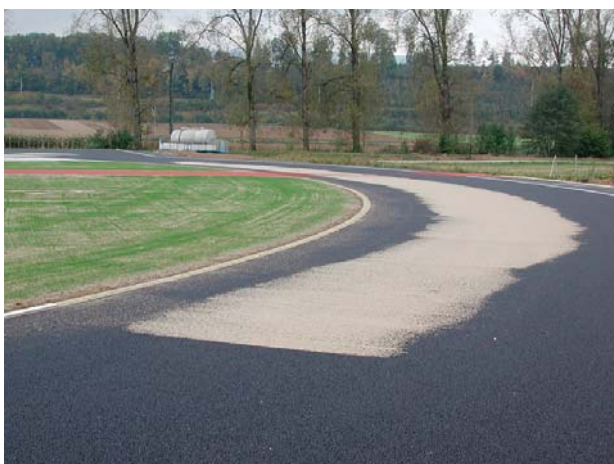
Rabottage et reflâchage des irrégularités
