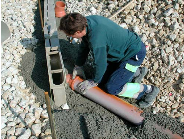
Pose du drainage
