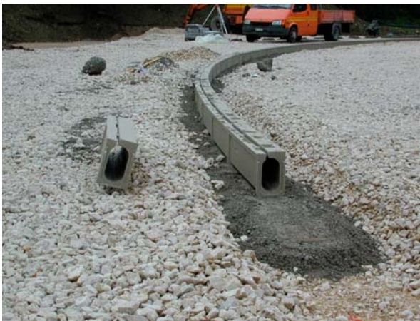
Pose du drainage
