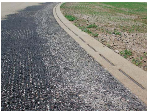
Rabottage et reflâchage des irrégularités
